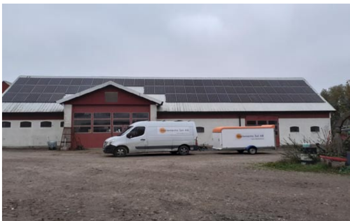
Ovansynen nätansluten installation på ett lantbruksgjord av Implementa på 24,4 kWp som driftsattes i december 2020 i Trelleborg.
